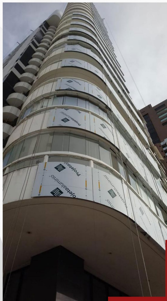
edf. mansão victory side | corredor da vitória
